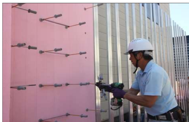
無足場工法による施行中の写真
