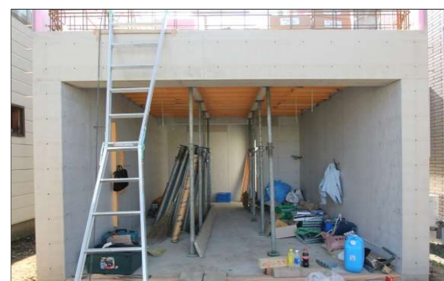
コンクリート打設するだけで精密な躯体・断熱・外装・内装・開口が出来る自動多能工
