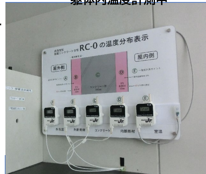
躯体内温度計測中
